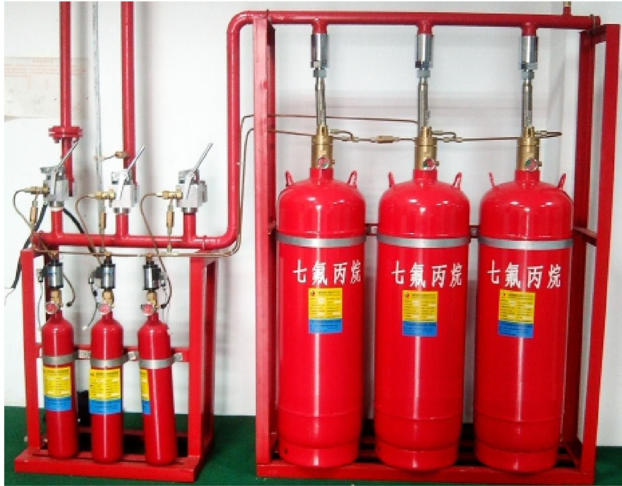
七氟丙烷(HFC-227ea)灭火剂无色、无味,其臭氧损耗潜能值(ODP)为零,在IOS认可的洁净气体灭火剂中,其清洁性最好,具有清洁、抵毒电绝缘性能好、灭火效率高等特点。关键部位采用新材料,产品性能可靠,其主要指标达到国内领先水平,保险系数大、工作可靠、操作维修方便。同时具有自动、手动和机械应急启动等多种方式,系统安全可靠。
